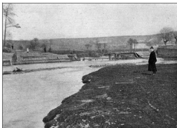
Obr. 2.6 Strž cacovického jezu způsobená třenicí ledu 28.12.1902
