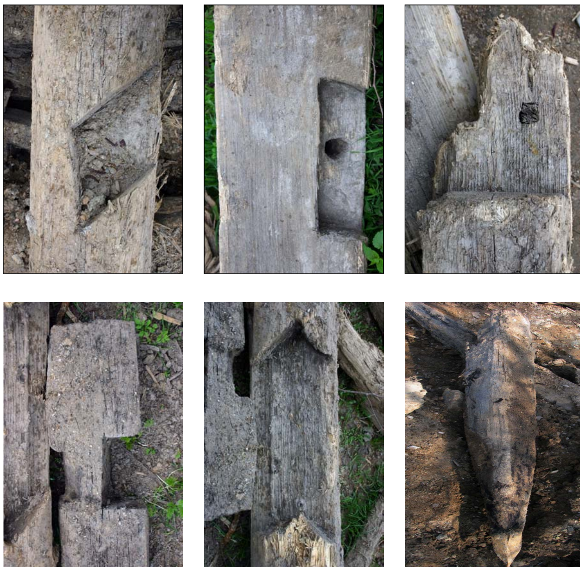
Obr. 10 Kapsy dlabaných spojů, pilot se železnou botkou
