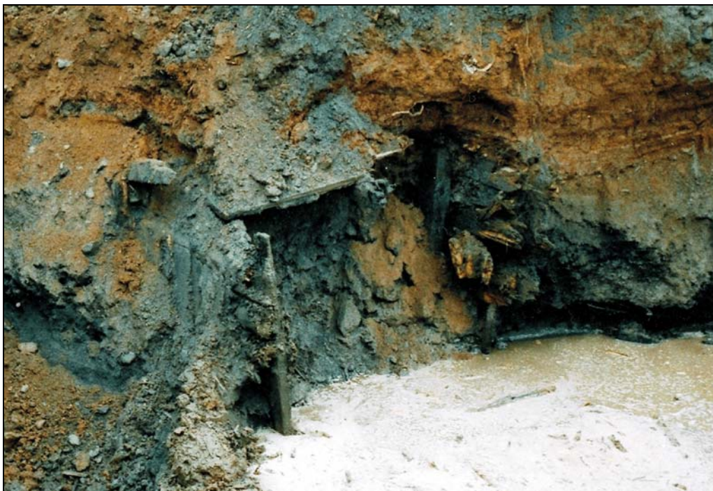
Obr. 6 Pohled do stavební jámy s torzem dřevěné konstrukce
