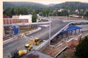
mimoúrovňová křižovatka v době stavby
