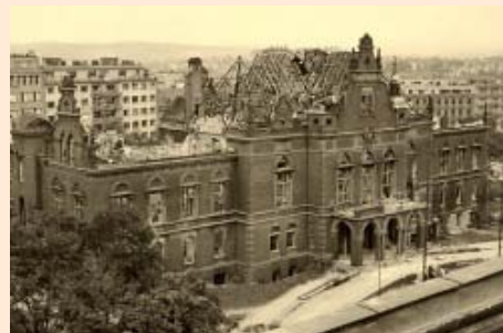
bourání Německého domu
