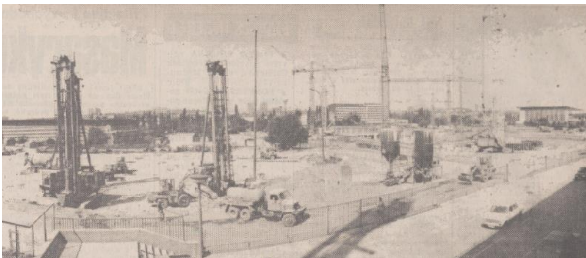
Obrázek 34: Staveniště v oblasti za Lužánkami ( Rovnost . 3. 7. 1992, 2 (107)(155), s. [8]).
