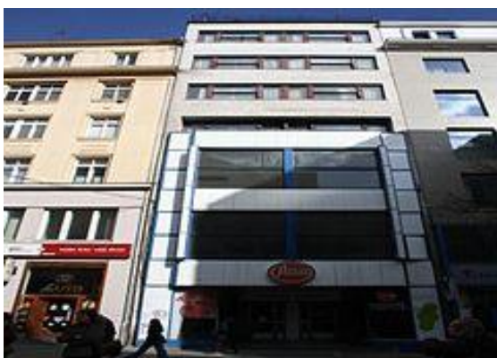
Foto 3 Hotel Avion Brno, Česká ulice
