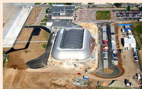
výstavba odbavovacího terminálu
